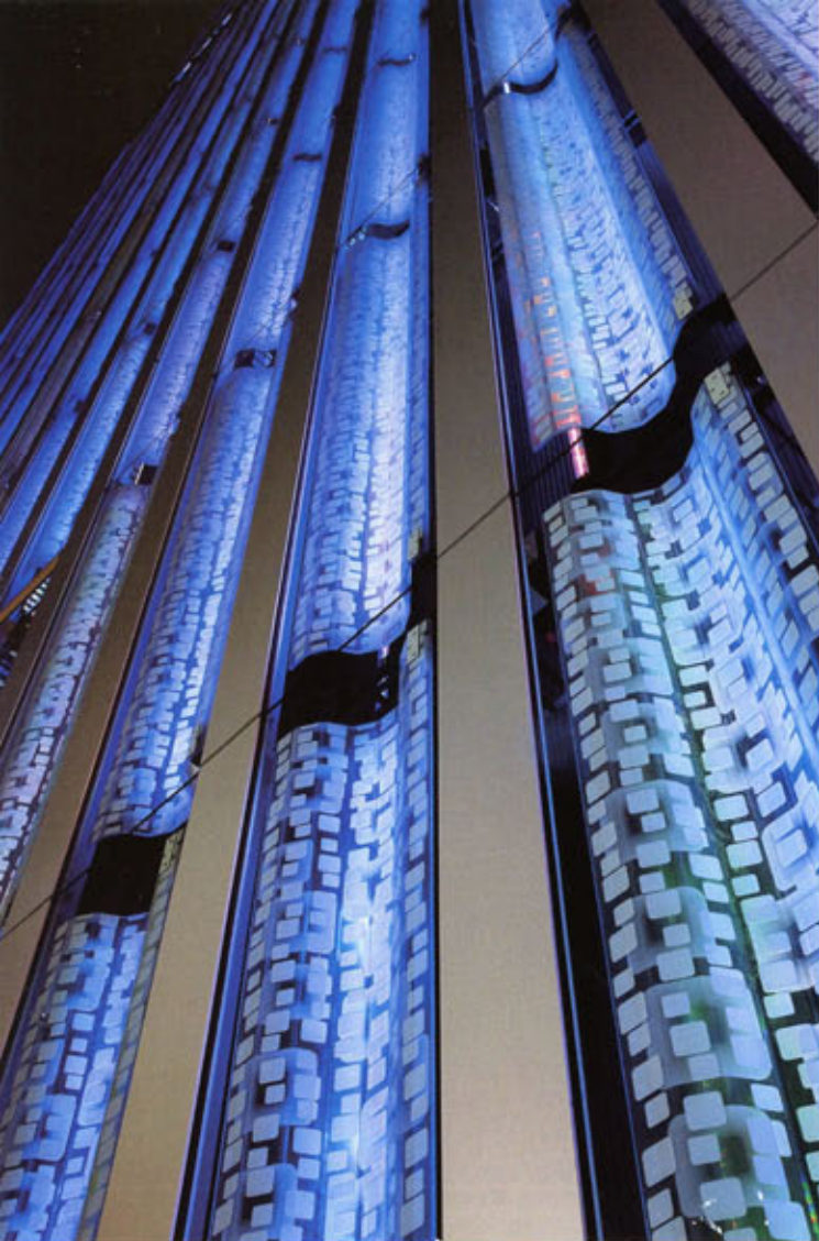
ファサードを見上げる。ダブルスキンのマリオン内部に内蔵されたLED照明がパネルを照らす。
