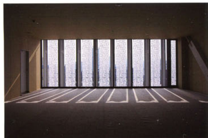
ダブルスキンに内蔵されたポリカーボネート製の可動パネル。表面には細胞を彷彿とさせるパターンが施されている。
