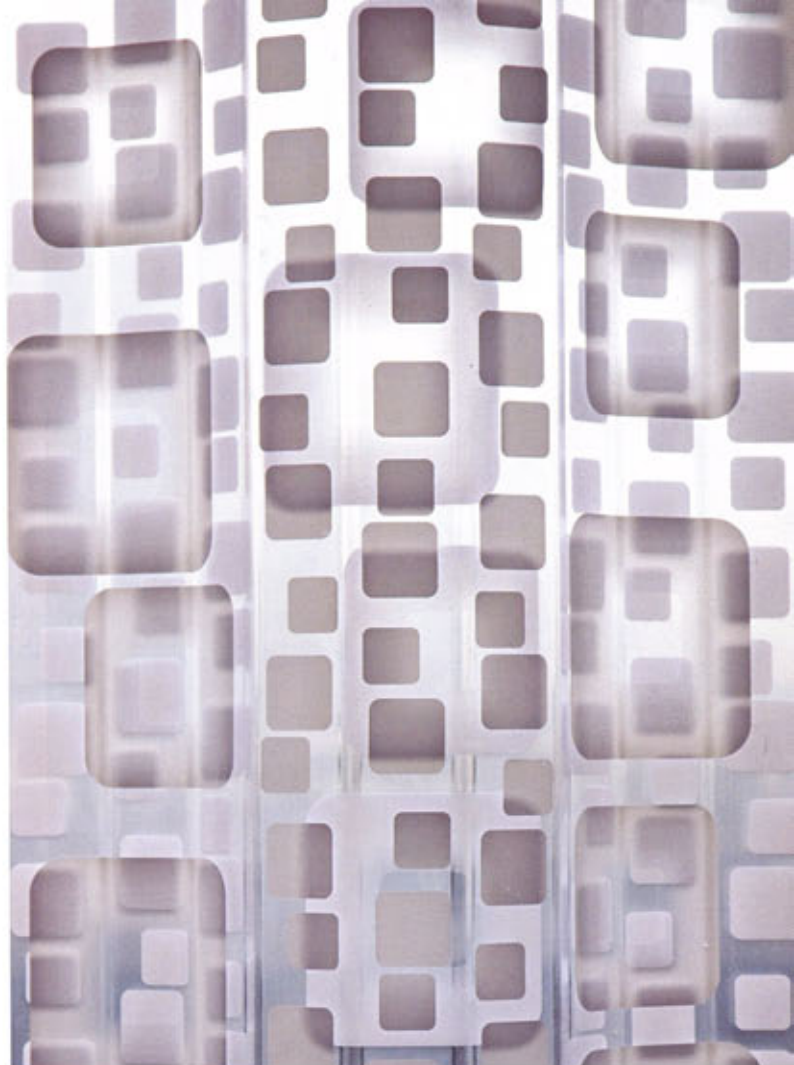
ダブルスキンに内蔵されたポリカーボネート製の可動パネル。表面には細胞を彷彿とさせるパターンが施されている。
